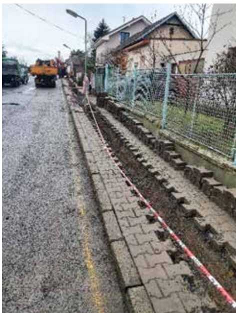
Výměna kabelu veřejného osvětlení
