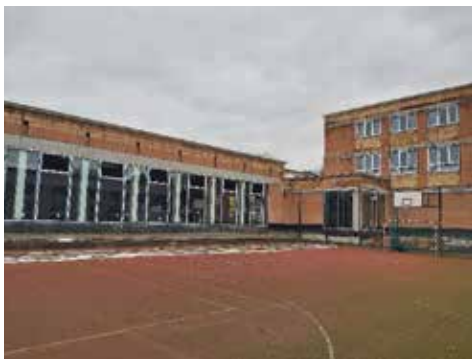
Vstupní hala a nový pavilon G
