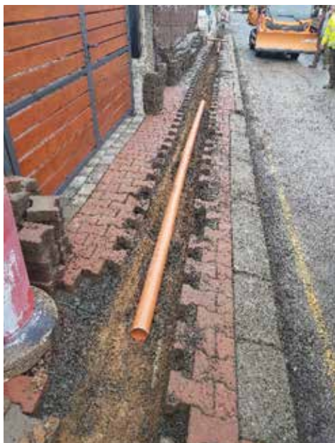
Výměna kabelu veřejného osvětlení
