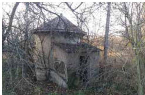
Mokřad, aktuální stav – stará vodárna II
