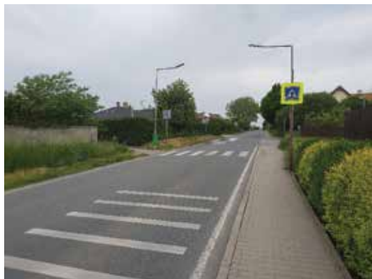
Přechod v ulici Topolová je vybaven bezpečnostními prvky
