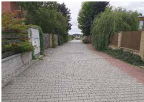
Na základě četných žádostí občanů připravujeme stavební úpravy komunikací na Boleslavce, které povedou ke zklidnění dopravy
