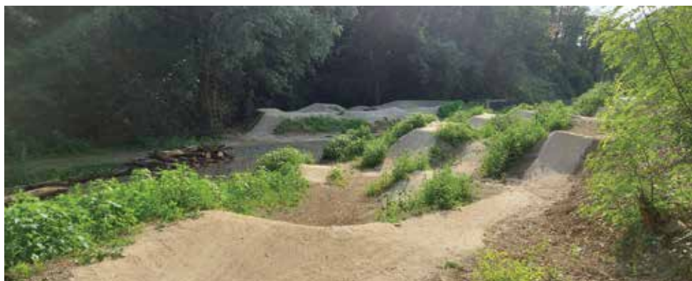
Pumptrack nečekaně rychle zarůstá plevelem
