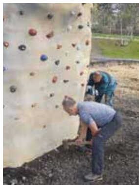
Montáž boulderové stěny
