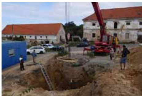
Oprava studny se snížením přístupu
