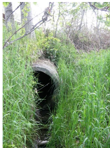
Obr. 13 Vyústění propustku pod ulicí Čsl. armády
