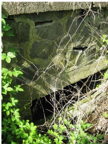
Obr. 12 Propustek pod ulicí Čsl. armády
