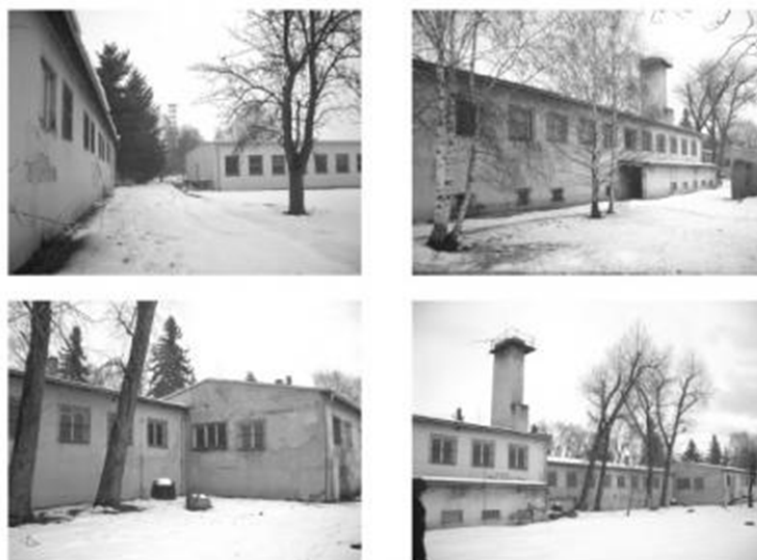
současný stav budovy - býv. výstrojní sklad
