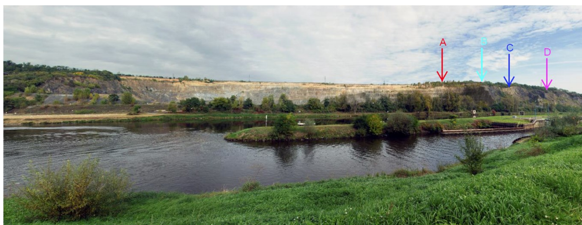
Stav území po realizaci záměru:
